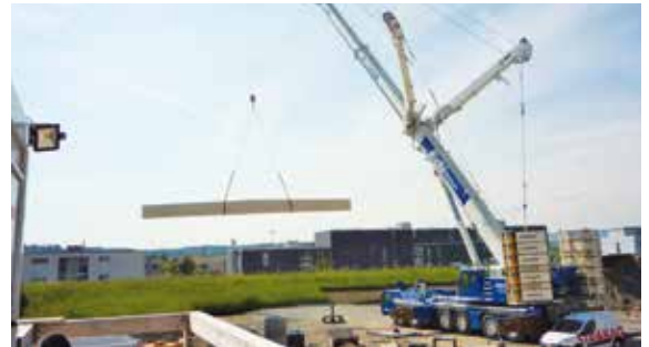
Präzisionsleistung: rund acht Tonnen schwere Holzträger mussten auf dem Dach platziert werden
