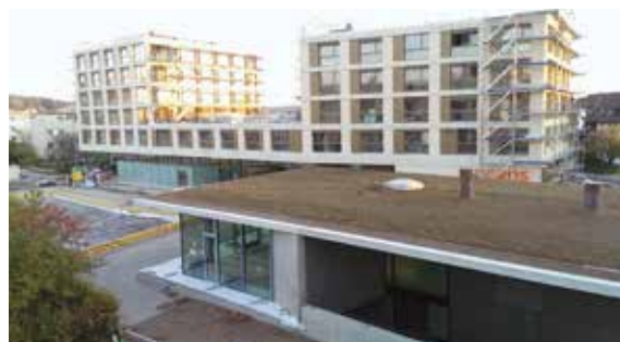
Neubau Dorfzentrum Bassersdorf
