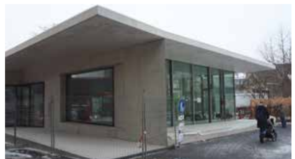
Neuer Pavillon Dorfzentrum
