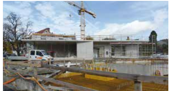
Bauarbeiten am neuen Dorfzentrum.
