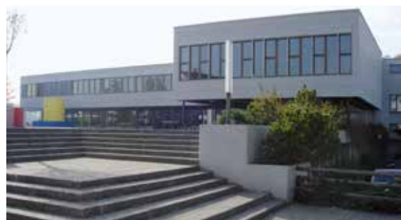
Heizung der Schulanlage Geeren musste saniert werden.
