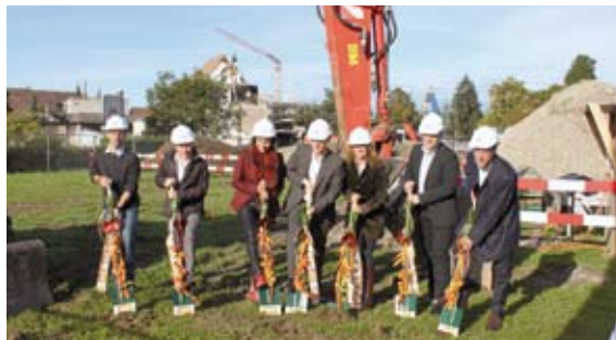
Spatenstich zum Dorfzentrum.
