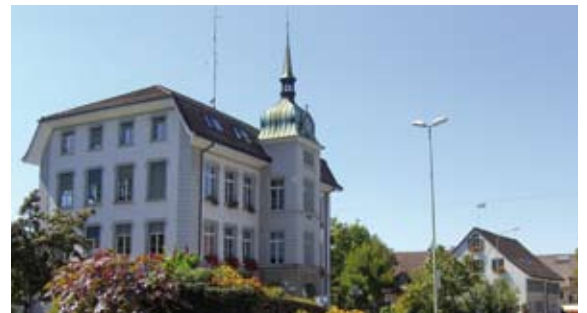
Aufwendige Reparaturarbeiten nach Sturmschäden.
