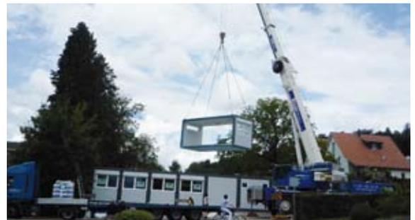
Der Schulpavillon an der Steinligstrasse wurde aus einzelnen Containerelementen zusammengesetzt.
