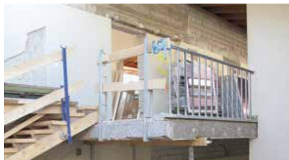
Start der Renovationsarbeiten im Schulhaus Mösli
