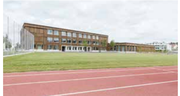
Das Schulhaus Chrüzacher steht pünktlich zur Aufnahme des Schulbetriebes bereit
