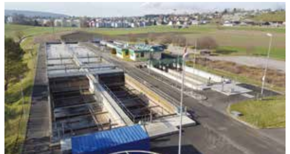
Die ARA Eich im Vorfeld der notwendigen Ausbauten zur Ertüchtigung
