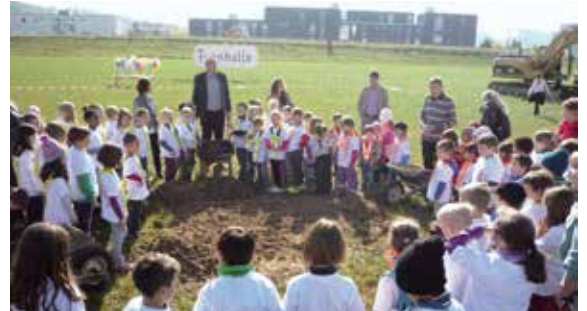
Mit dem Spatenstich beginnt für gross und klein der Bau des neuen Schulhauses
