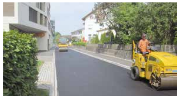
Deckbelagseinbauten in rundum heissem Umfeld
