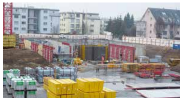
Ende Jahr wurde schon heftig am Untergeschoss gebaut
