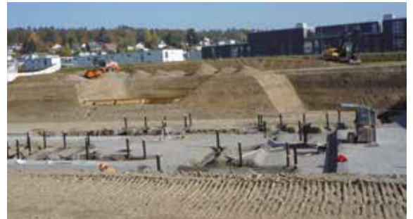
Dank dem guten Wetter gehen die Bauarbeiten zügig voran
