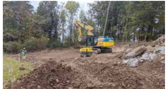
Umfassende Arbeiten waren zur Sanierung der Kugelfänge der Schiessanlage Baltenswil erforderlich
