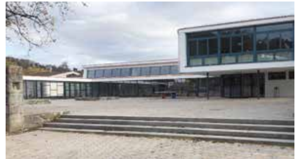
Die umfassende Sanierung des Schulhauses Steinlig wurde im Herbst erfolgreich abgeschlossen
