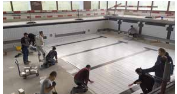
Verzögerungen und Zusatzkosten mussten bei der Hallenbadsanierung in Kauf genommen werden
