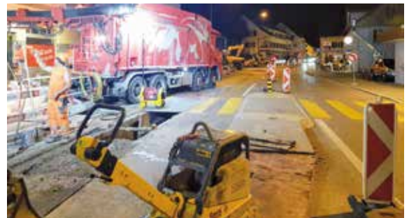
Die Sanierung Klotenerstrasse erfolgte zeitweise in Nachtarbeit
