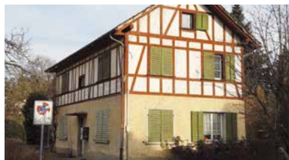
Die Asylsuchenden werden in Bassersdorf dezentral in Liegenschaften betreut
