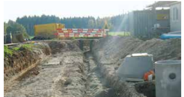
Der zweite Teil der Erschliessungsanlagen Rüti ist erstellt
