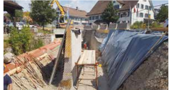
Neue, hochwassersichere Bachverbauung bei der Schmitte
