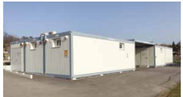
Die sanierten Garderoben auf dem Fussballplatz Acherwis: Schlicht, ökologisch sinnvoll und zeitgemäss
