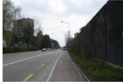
unwirtlicher Strassenraum X
