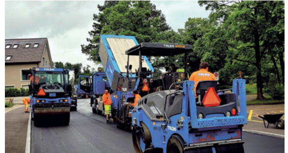
Deckbelagseinbau mit Vollsperrung.
