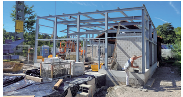
Der Stahlbau des neuen Rechenhauses Dolchen.
